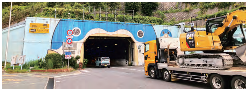
「ふくトンネル」の愛称で呼ばれる関門トンネル
